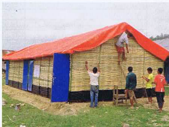
Bau eines provisorischen Lernzentrums
